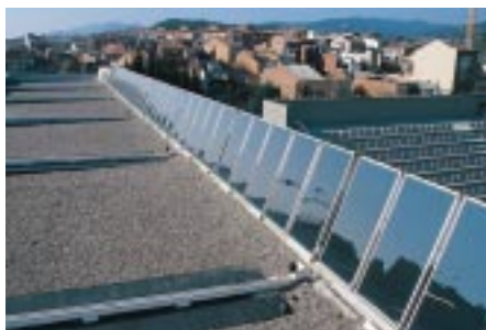
Vista dels captadors solars que cobreixen una superfície de 85,2 m 2 .
