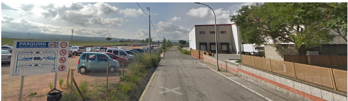
Carrer del Camí ral en direcció sud, amb la fàbrica Monells i l'espai d'aparcament pels treballadors
