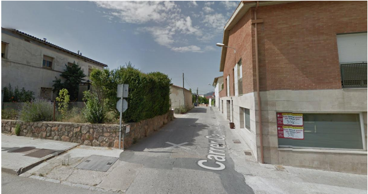
Cantonada del Carrer del Camí ral amb la carretera BV-5303, per on circulen els camions en els dos sentits
