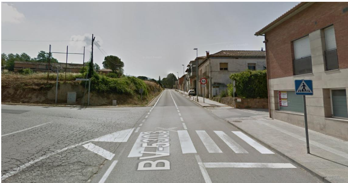
La carretera BV-5303 en la trobada amb el carrer del Camí ral
