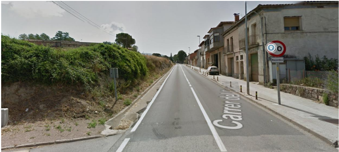
La carretera de Seva en la confluència amb el carrer del Camí ral
