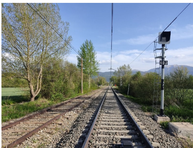
Imatge 4.14. Doble via al tram entre la Tor de Querol – Enveig i Puigcerdà, amb via d'ample estàndard (a l'esquerra, en desús) i via d'ample ibèric (a la dreta)
