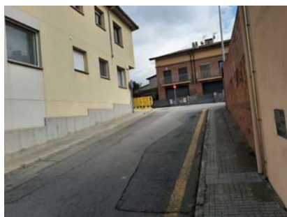
c. Cal de Can Bullit (tram 1026 ZEG)
